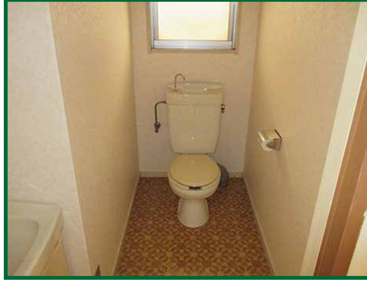
トイレ リフォーム前
