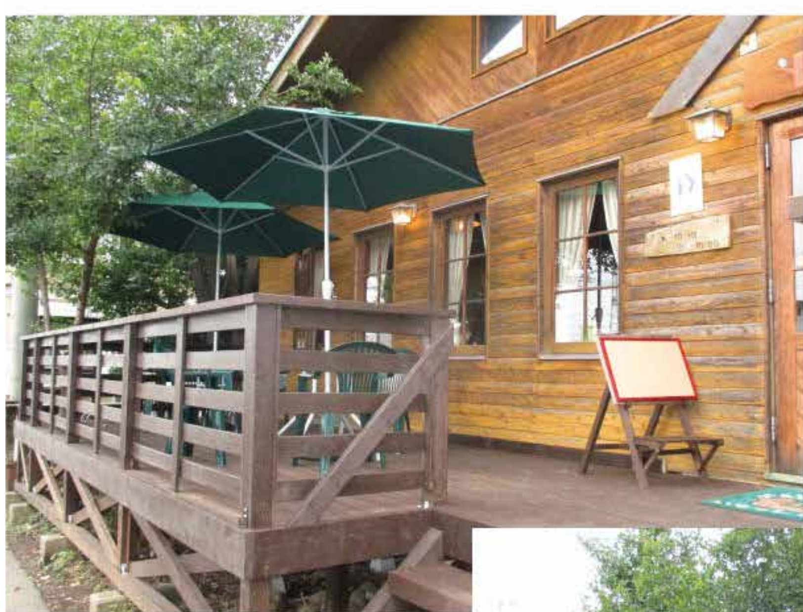
●カフェテラスロッジ リフォーム後
