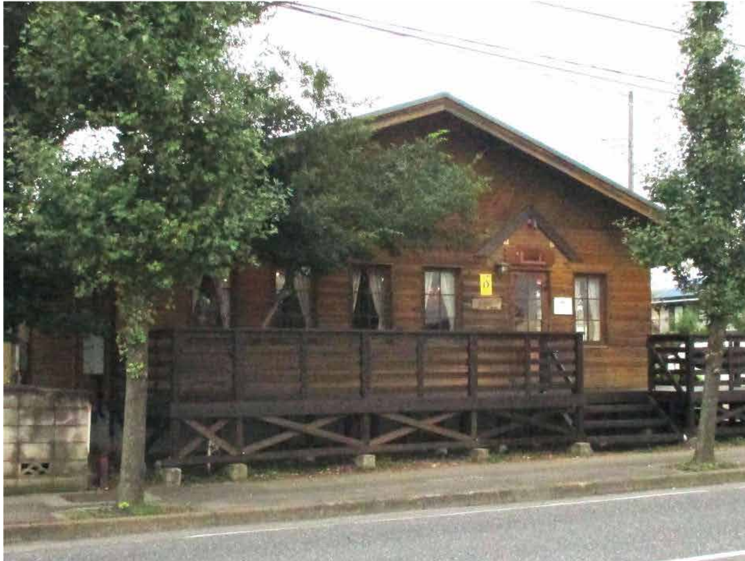
●カフェテラスロッジ リフォーム後
