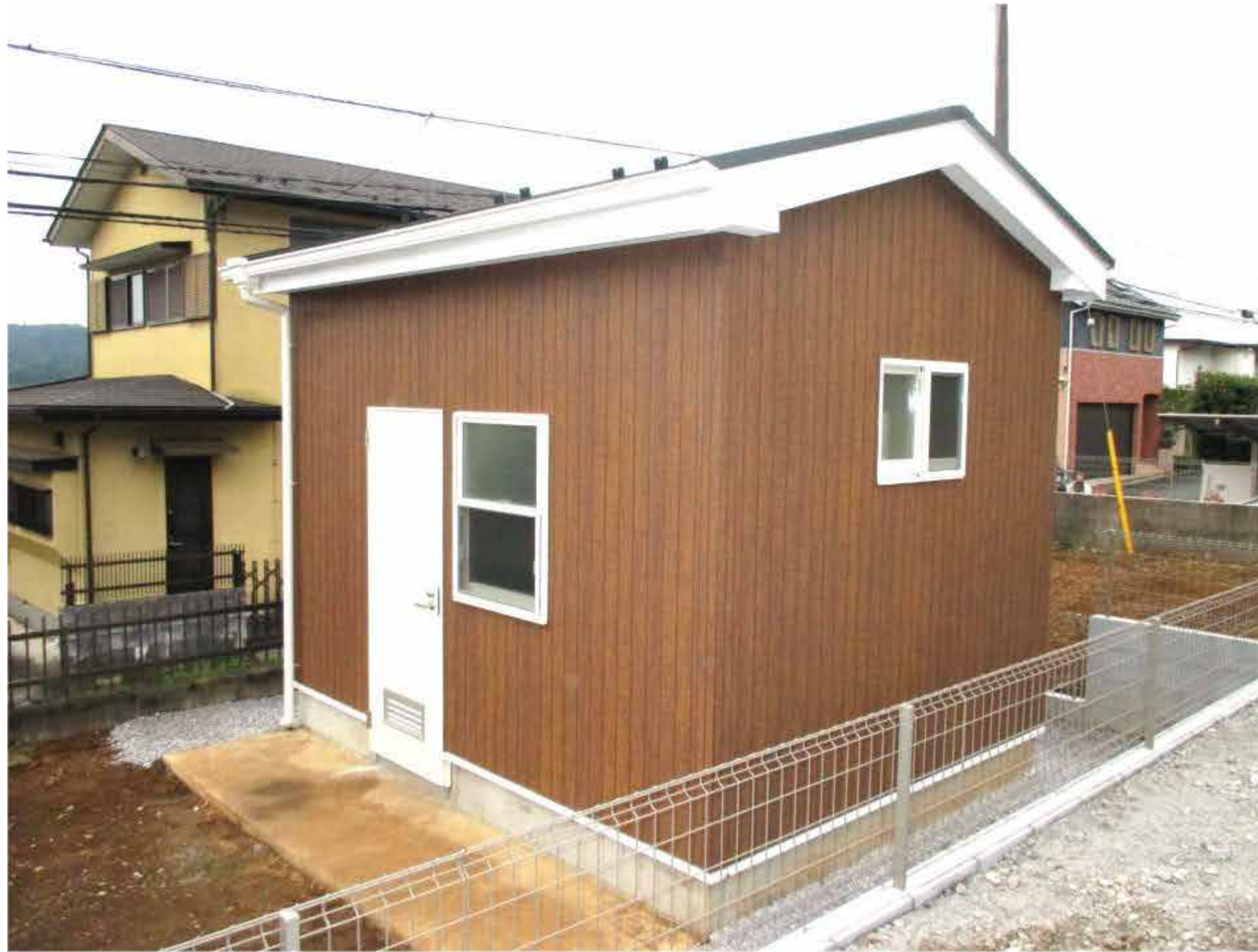
●物置小屋 増築
