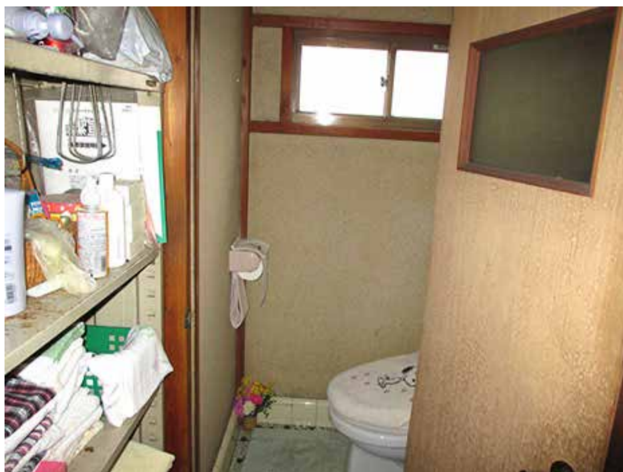
トイレ：リフォーム前
