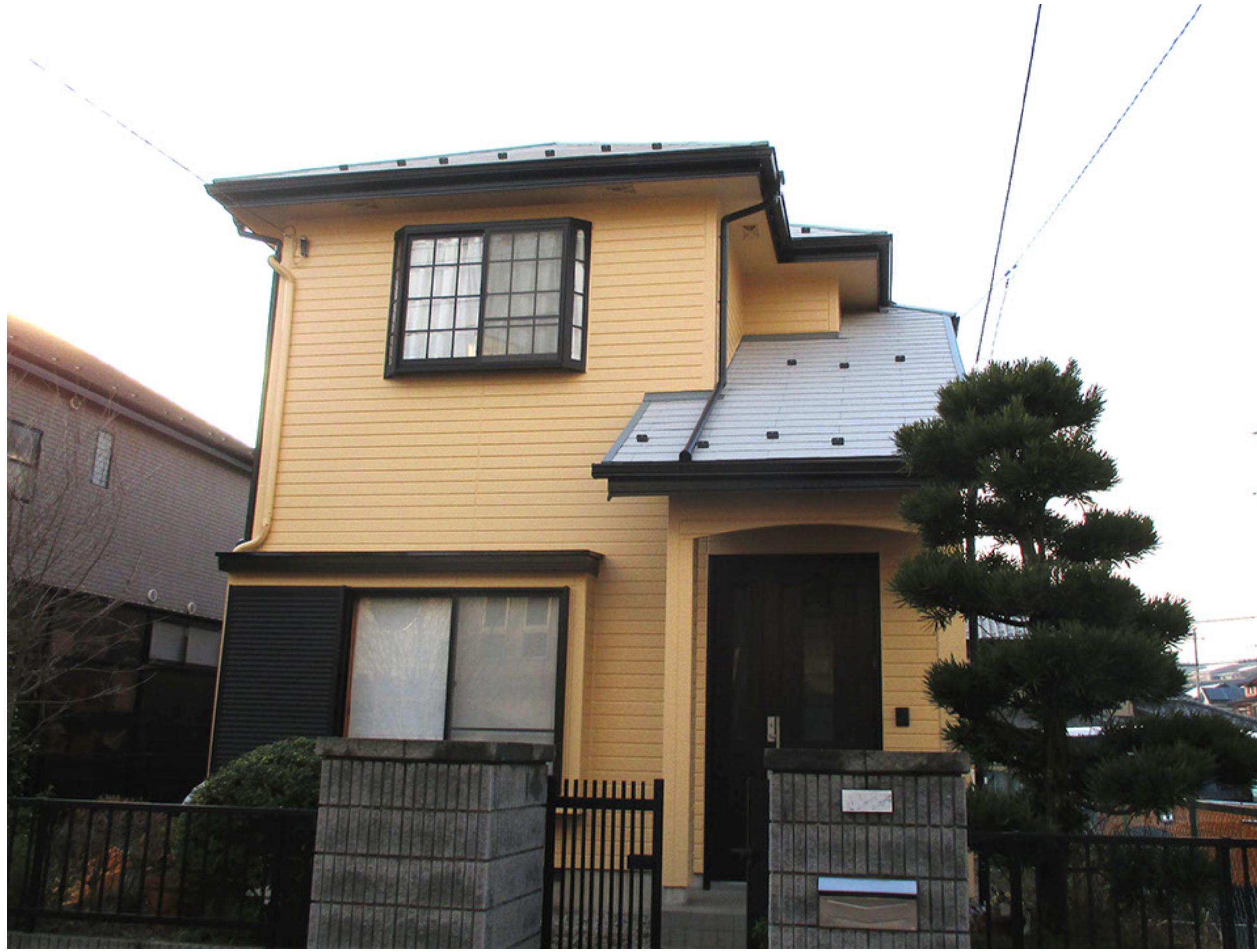
屋根吹替・外壁塗装：リフォーム後
