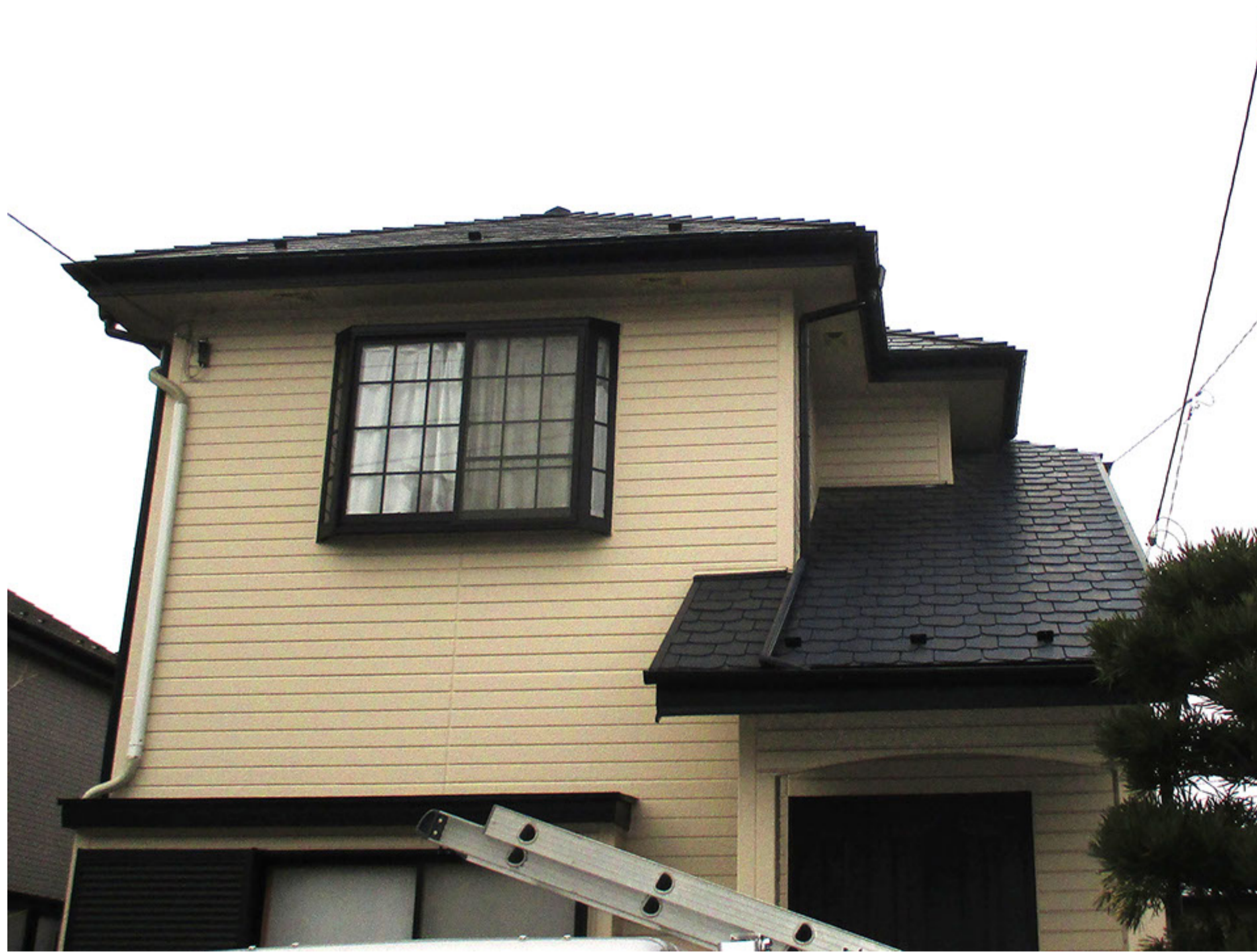
屋根吹替・外壁塗装：リフォーム前
