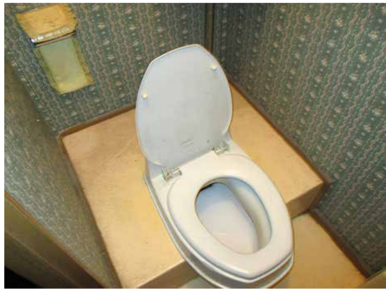
トイレ：リフォーム前
